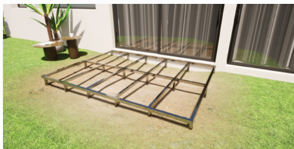
Punktfundament auf Sand und Erde
